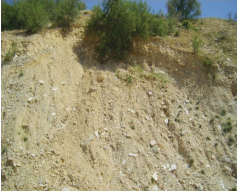
Şekil 9. Geriye dönük analizi yapılan pasa şevi duraysızlığı.
